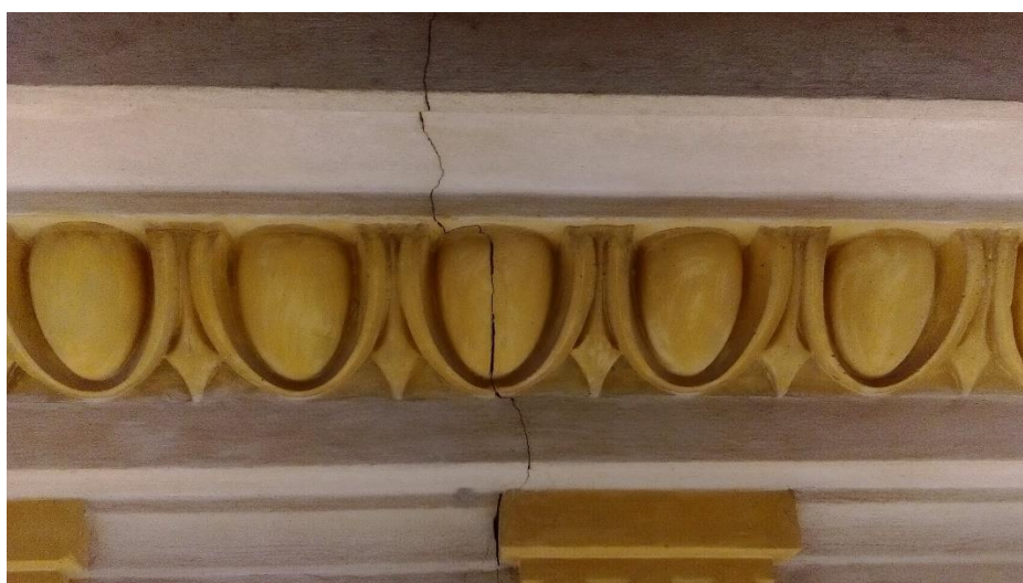
(Billede fra tidligere facaderenovering, 21.08.2018)
