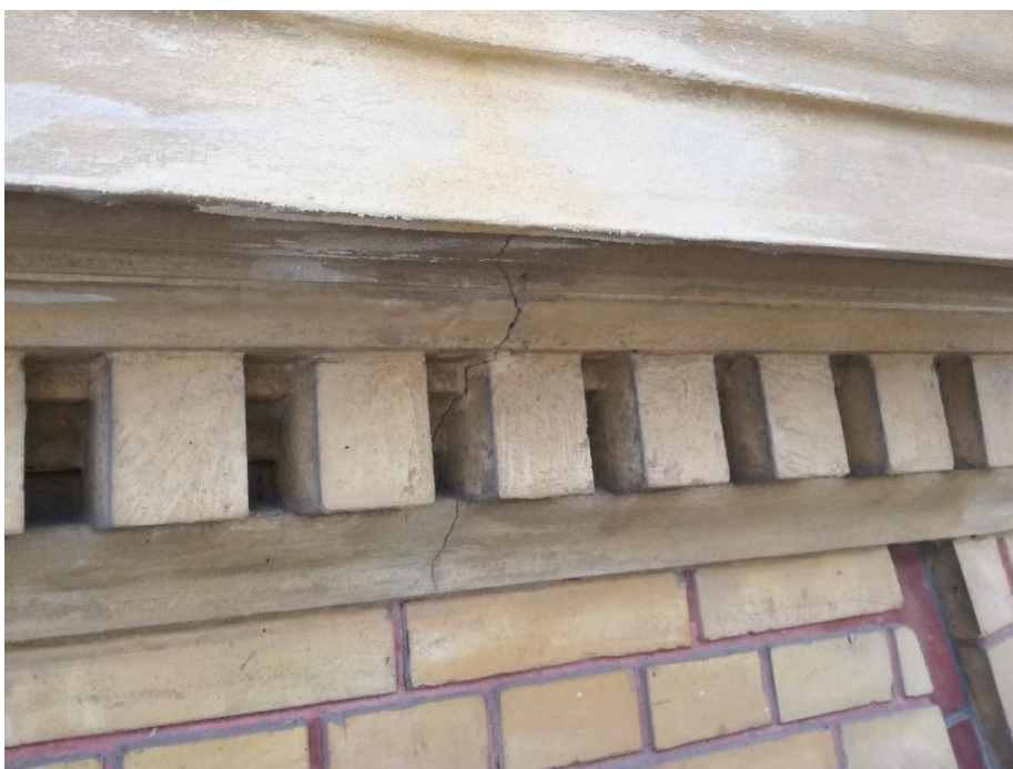
(Billede fra tidligere facaderenovering, 21.08.2018)
