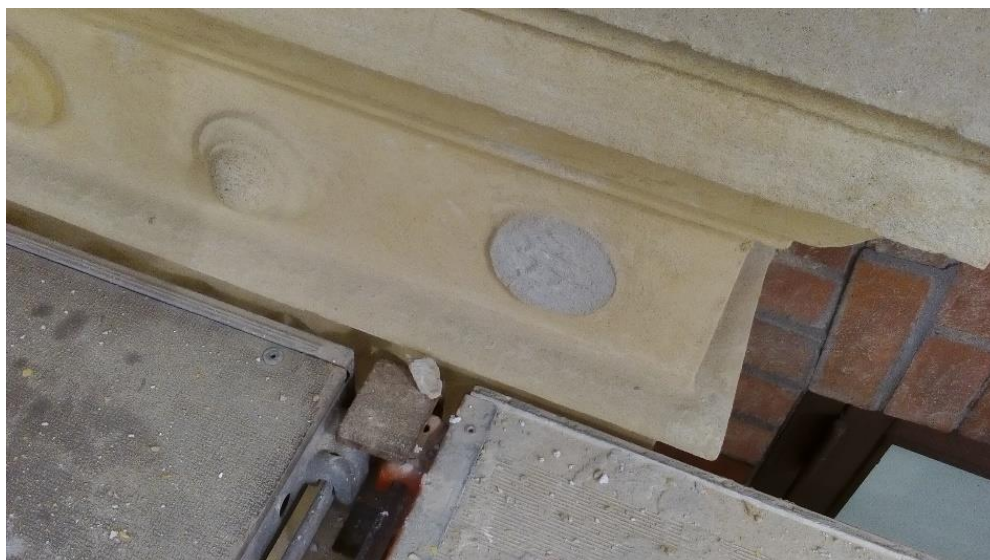
(Billede fra tidligere facaderenovering, 21.08.2018)
