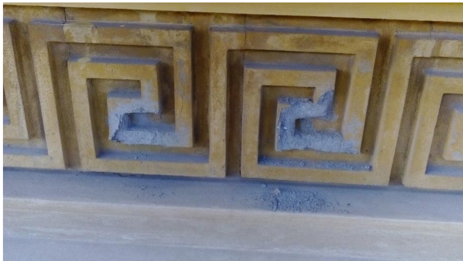
(Billede fra tidligere facaderenovering, 21.08.2018)
