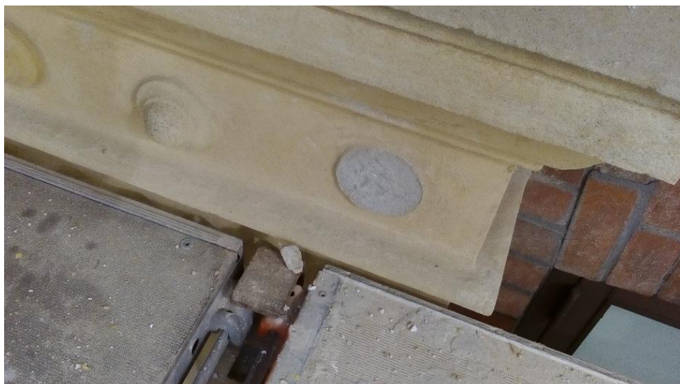
(Billede fra tidligere facaderenovering, 21.08.2018)
