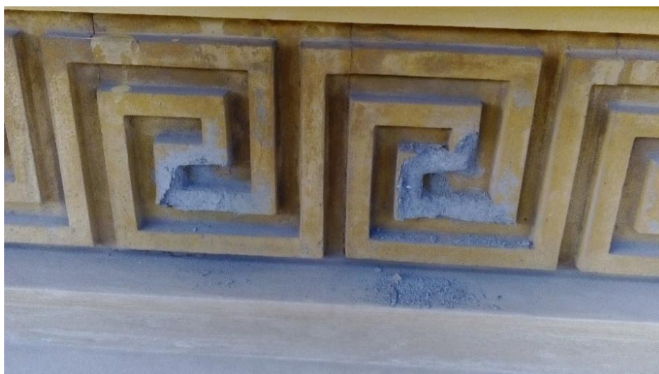
(Billede fra tidligere facaderenovering, 21.08.2018)
