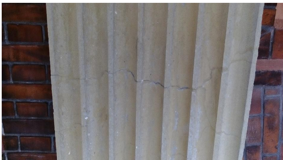
(Billede fra tidligere facaderenovering, 21.08.2018)
