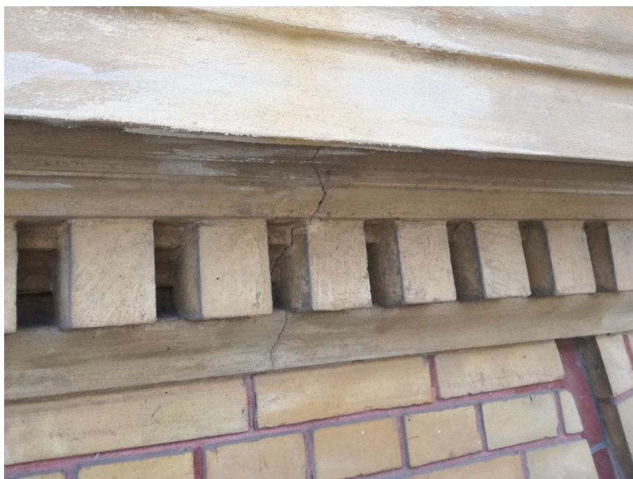
(Billede fra tidligere facaderenovering, 21.08.2018)
